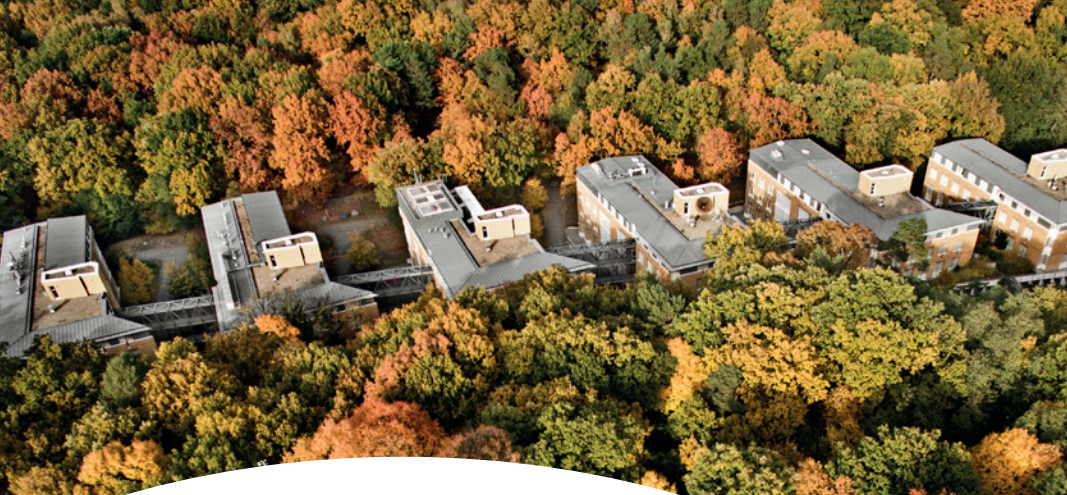
Luftaufnahme der GFZ-Gebäude B-G, Foto: JokeAir
